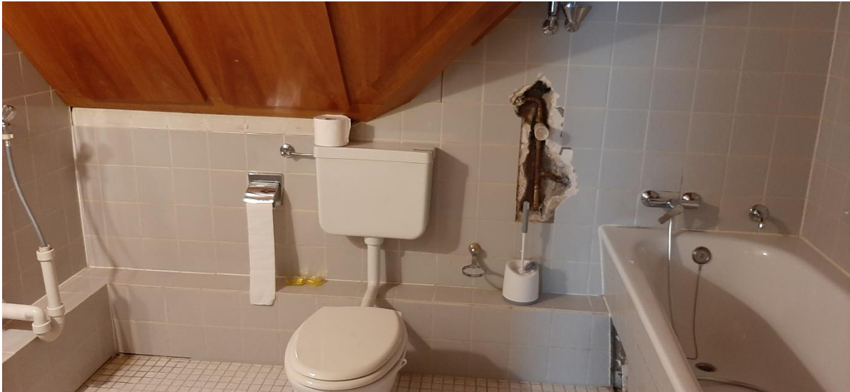
Bad, Wasserabsperventil der Wohnung erneuert
