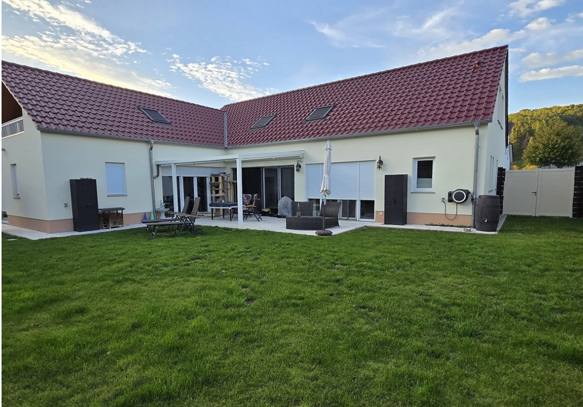
Garten mit Terrasse zur alleinigen Nutzung der Erdgeschoß-Wohnung.
