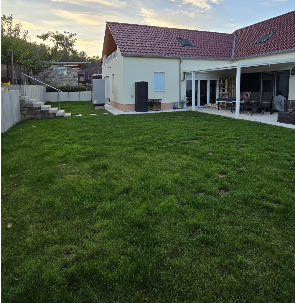
Blick vom Grundstückszaun in den Garten und auf die Terrasse Richtung Westen.
