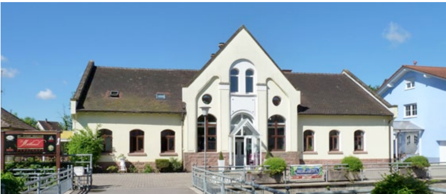
Hauptgebäude mit Restaurant (Mitte), Gastroküche (rechts), Galerie (oben) sowie Toilettenräume (links)
