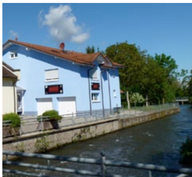
Südseite von der Zufahrtbrücke aus
