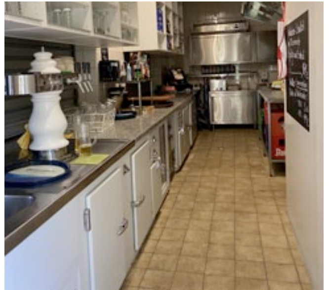
Kühltheke mit Zapfanlage
