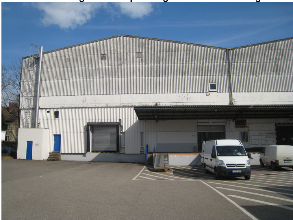
Halle 1 mit vorgelagerter Rampe
