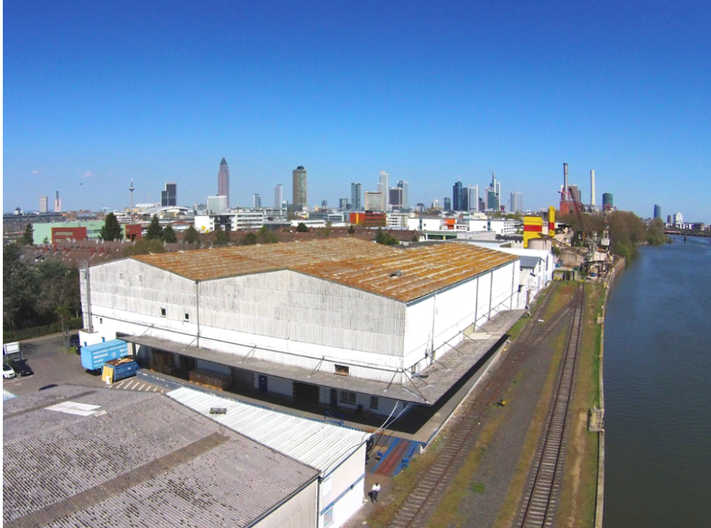
Halle 1: Zweigeschossige Lagerhalle Andienung über Rampe und grossen Lastenaufzug
