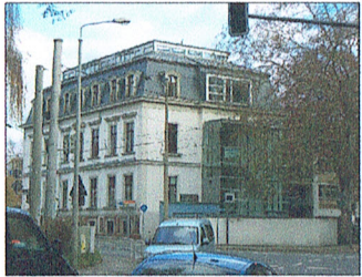
Ansicht Pfaffendorfer Strasse Ecke Uferstrasse
