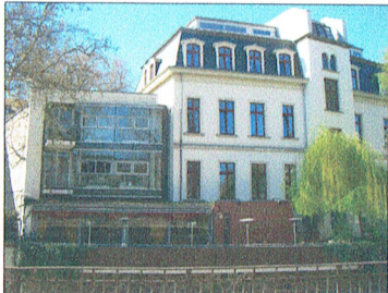
Ansicht Parthenstrasse Strasse
