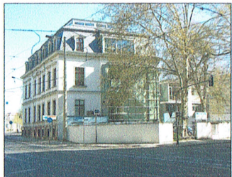
Ansicht Pfaffendorfer Strasse Ecke Uferstrasse
