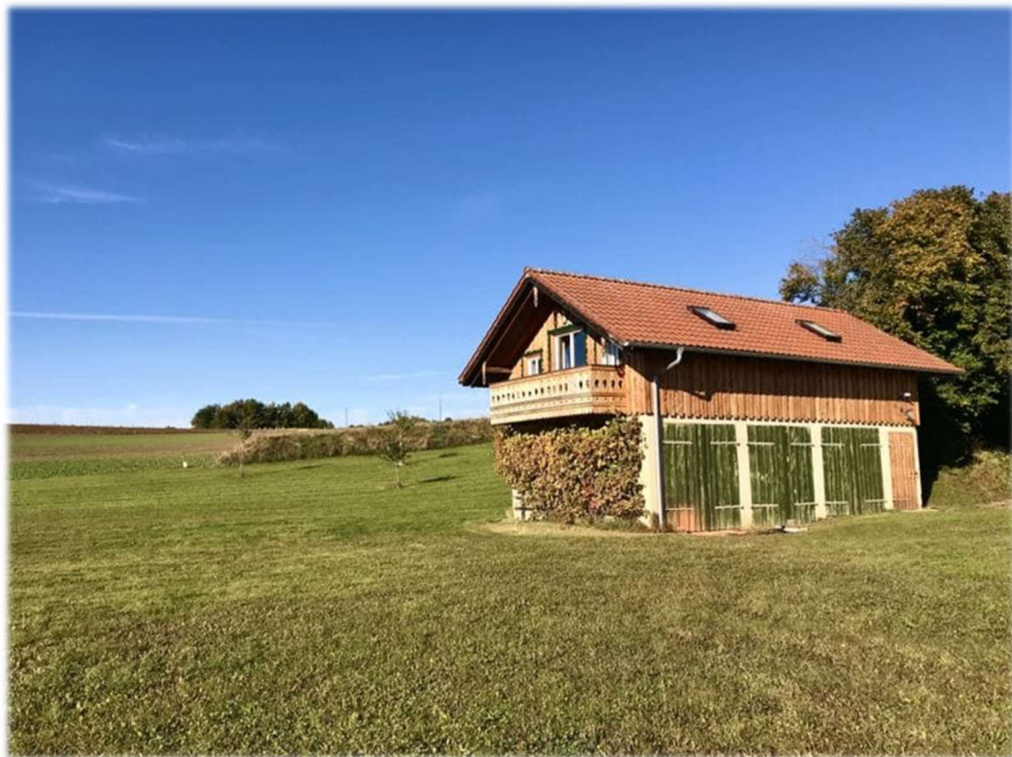
11. Bild: Südostansicht von der Remise mit Streuobstwiese im Hintergrund.
