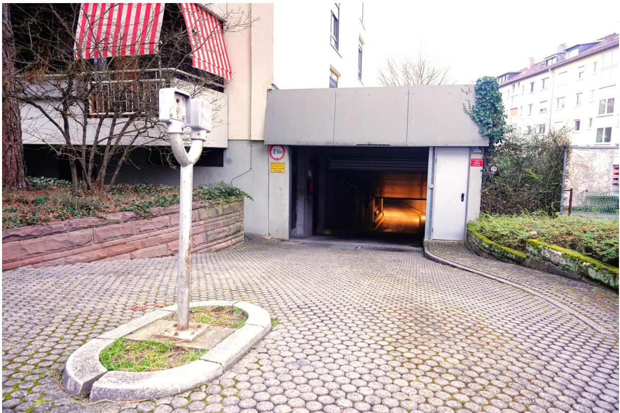
Tiefgarage von Straßenseite
