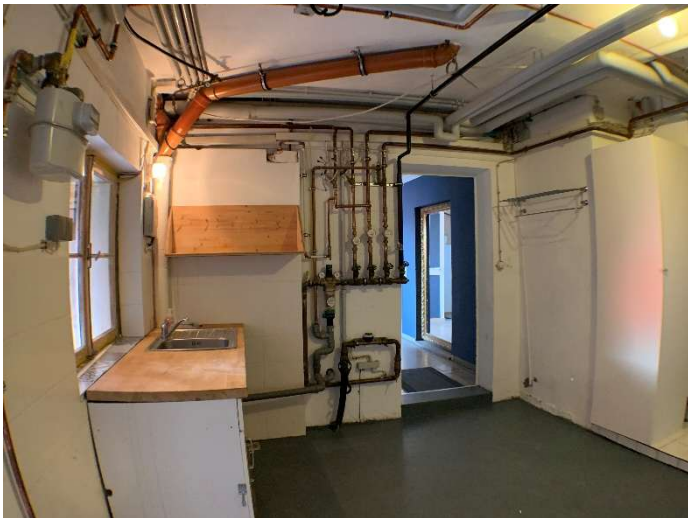
Hauswirtschafts- und Haustechnikraum
