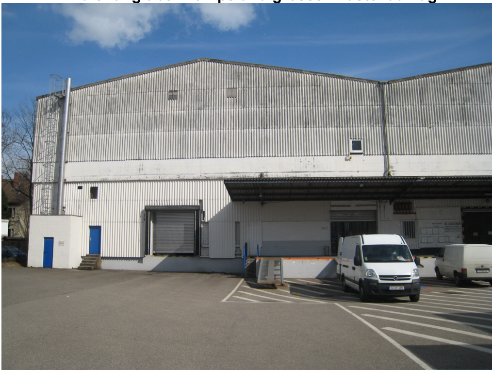
Halle 1 mit vorgelagerter Rampe
