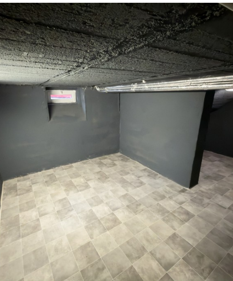
WEITERER BELEUCHTETER KELLER-ABSTELLRAUM
