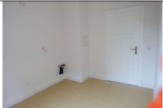
Küche, Anschlüsse für Küchenzeile
