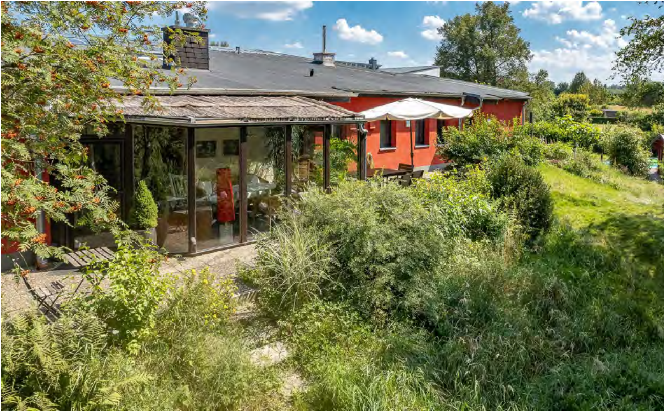
Westseite mit Wintergarten
