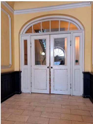
Flügeltür ins Treppenhaus
