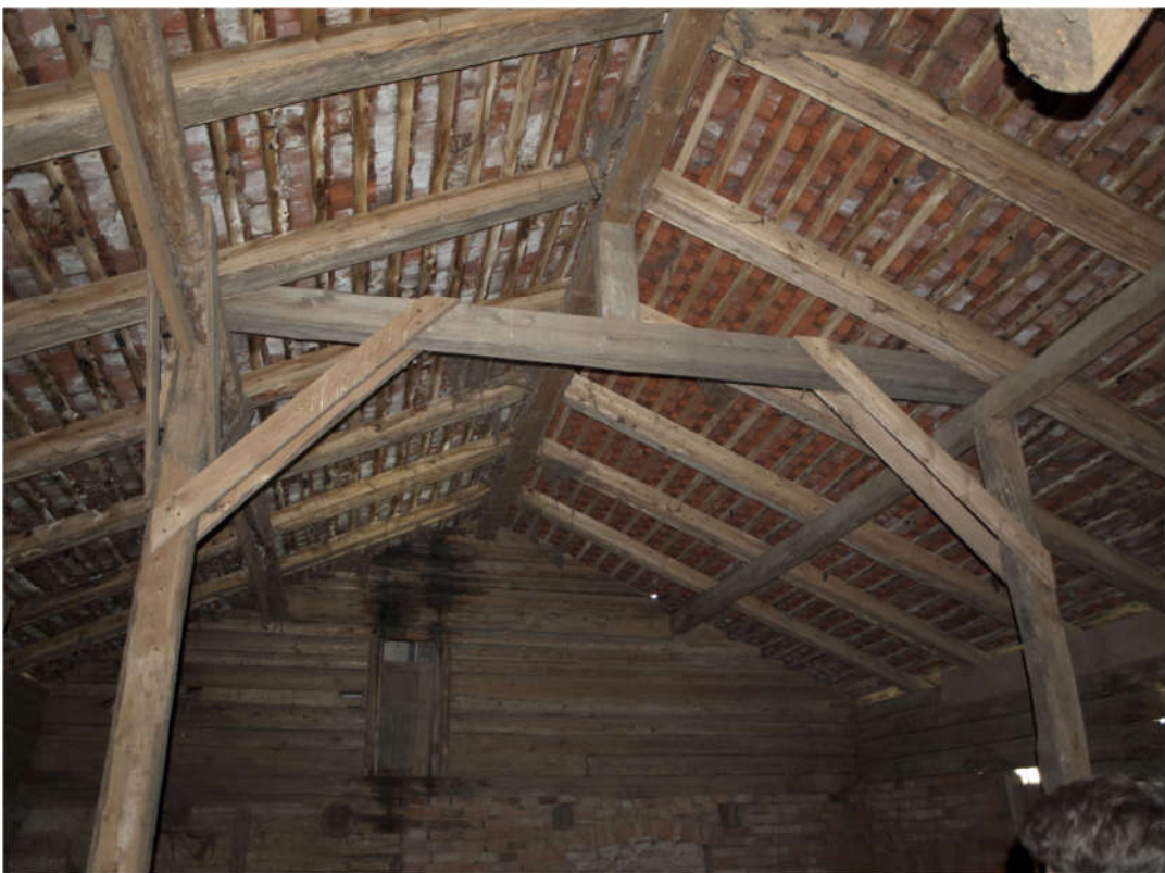
Innenansicht – Dachstuhl / Konstruktion
