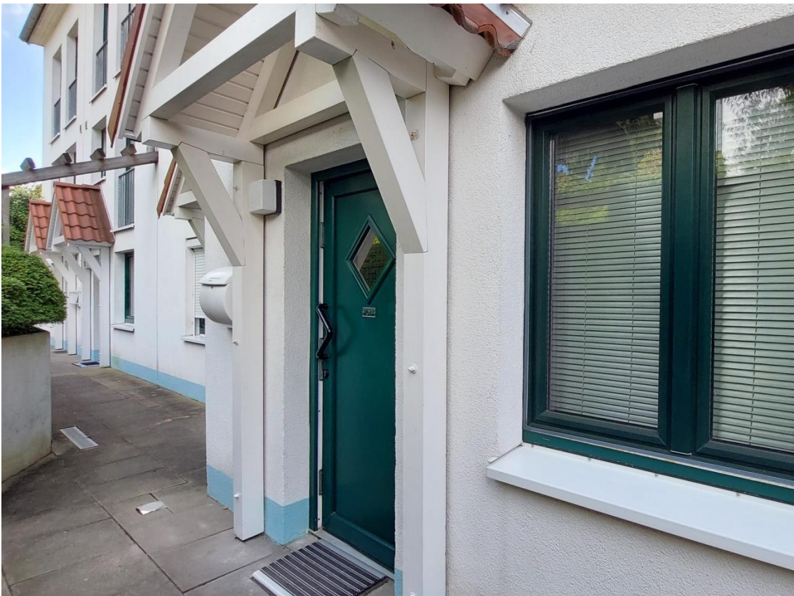
Überdachter Eingangsbereich im Souterrain
