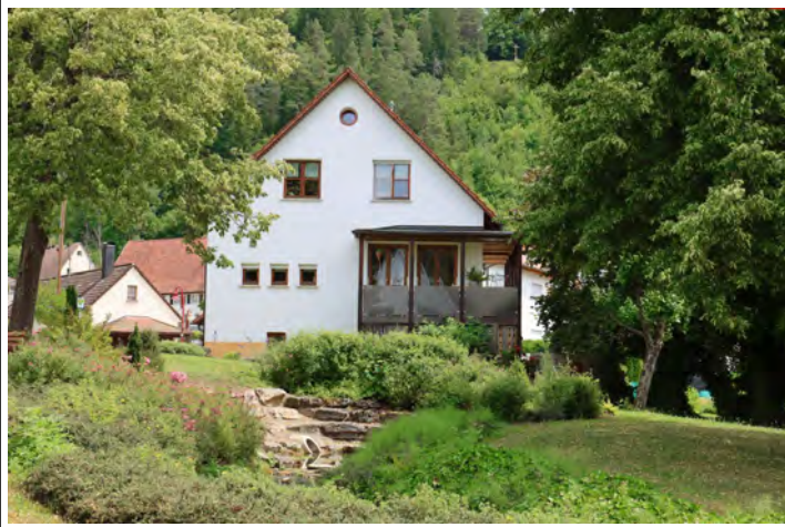
Westansicht mit Gemeindepark
