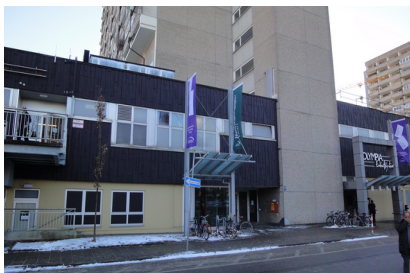
Nordseite OEZ mit Eingang Haus 65
