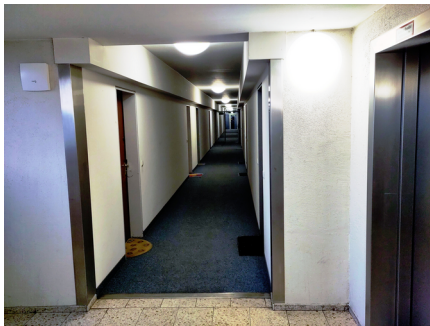
Flur (24h beleuchtet)
