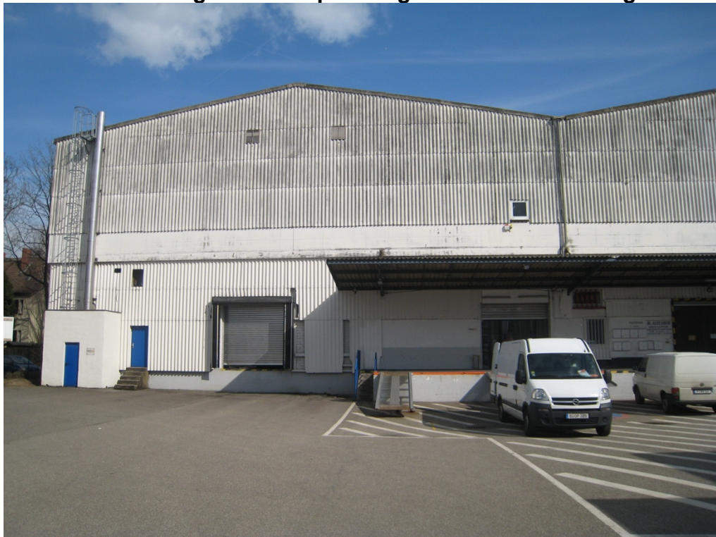
Halle 1 mit vorgelagerter Rampe
