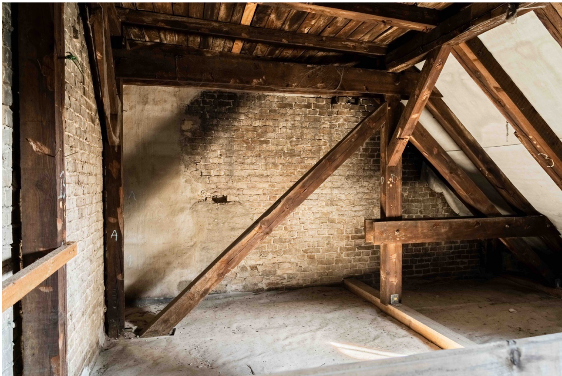
5. OG/ Dachgeschoss - Foto des aktuellen DG-Kaltdach-Rohlings
