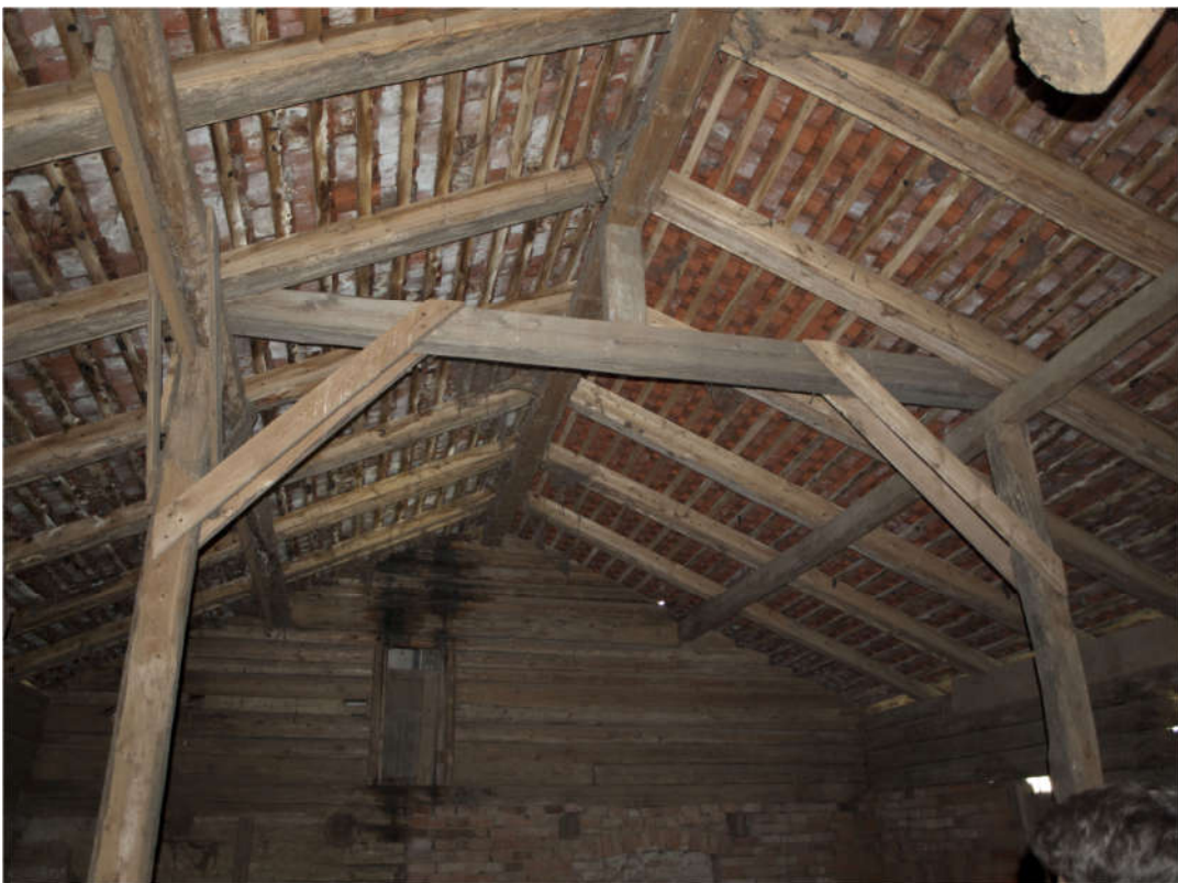
Innenansicht – Dachstuhl / Konstruktion
