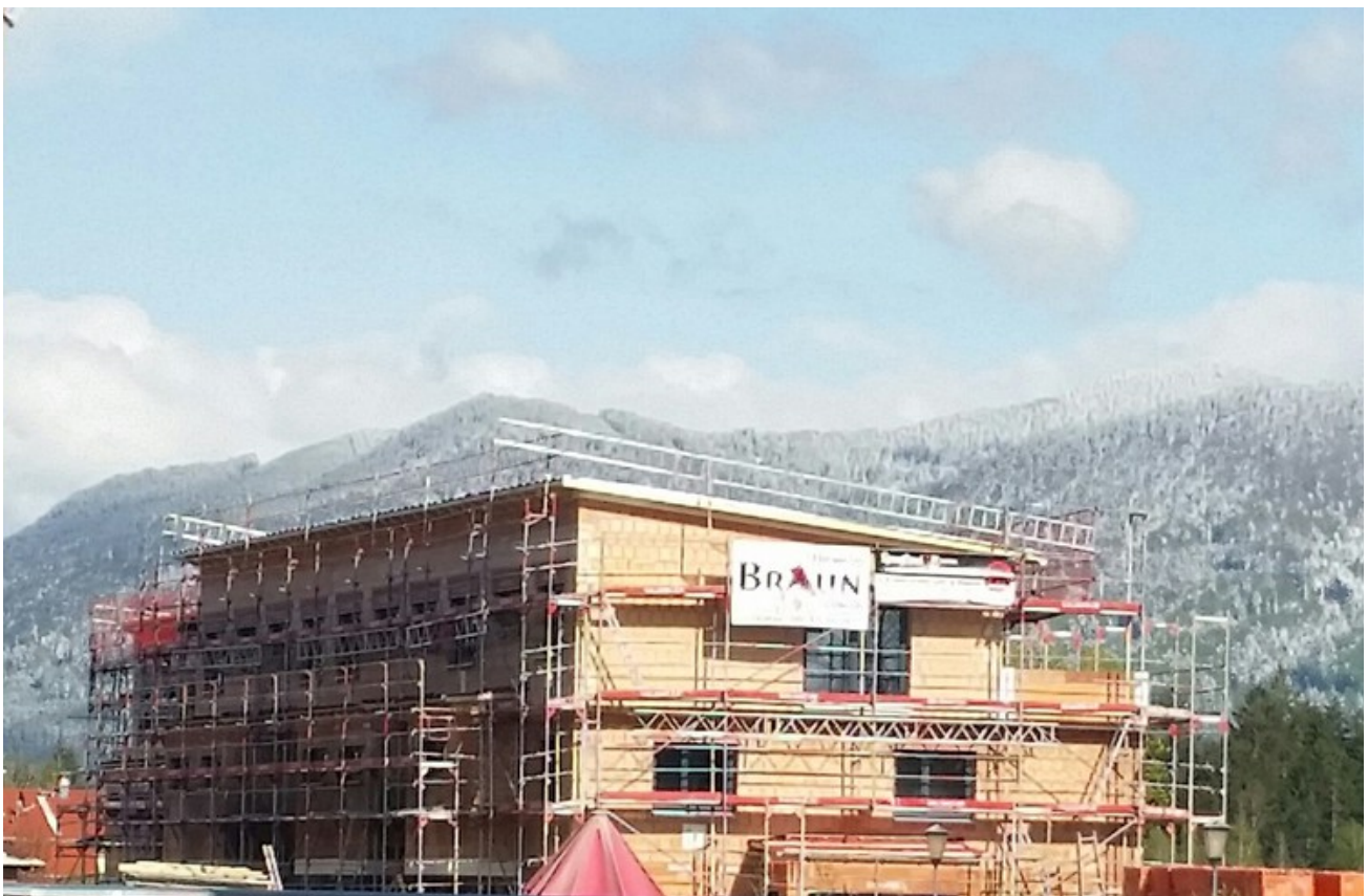
Rohbau Blick vom REWEParkplatz
