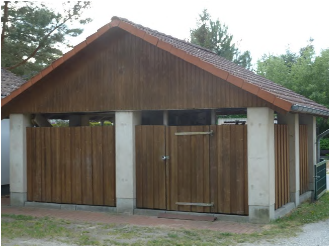
Carport (links) und Schuppen
