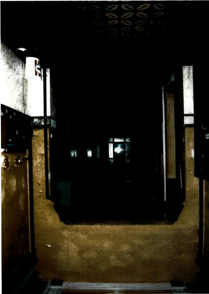
Marienburger Straße 39 vor der Sanierung
