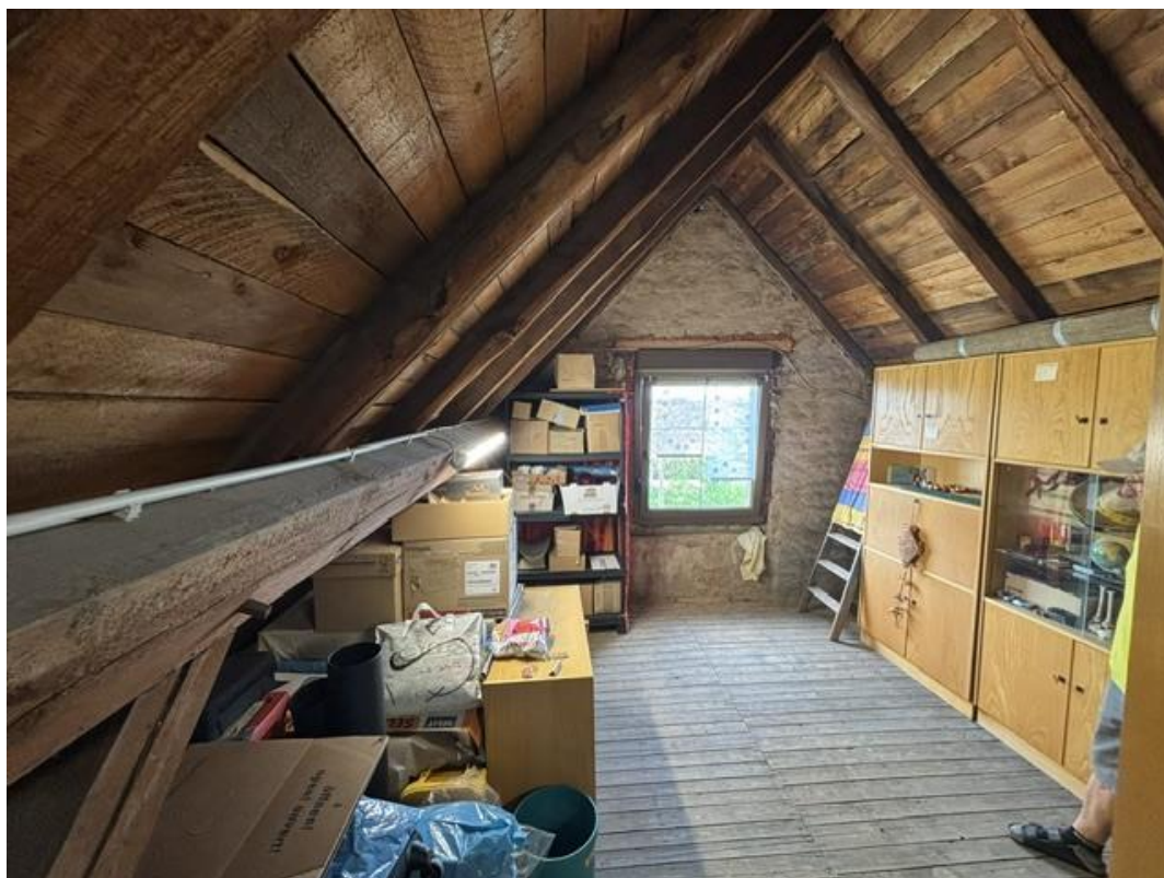
Bild 24 - Dachboden, Ausbaureserve, Holztragwerk
