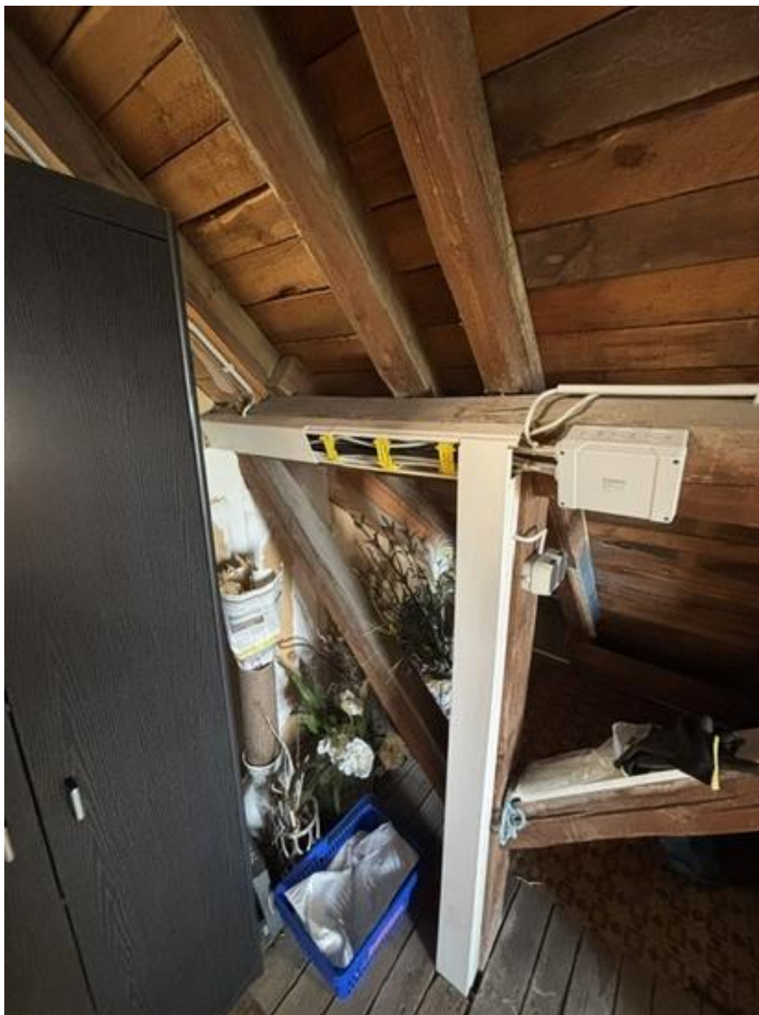
Bild 26 - Dachboden, Holztragwerk, Elektroinstallation
