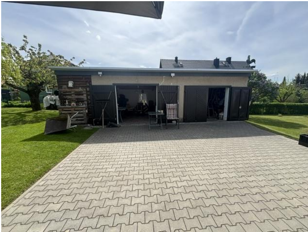
Bild 12 - Nebengebäude/Garage, Hoffläche, Stellplätze
