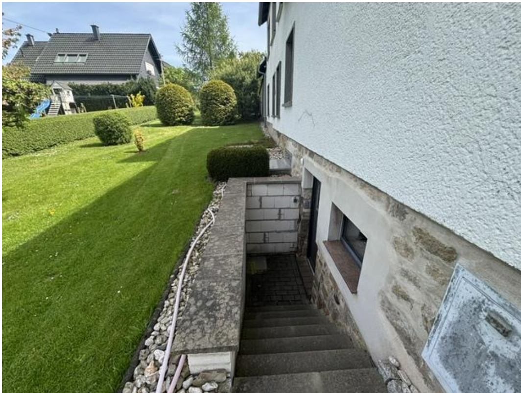
Bild 16 - Kelleraußentreppe, Zugang Kellereingang, Gartenansicht
