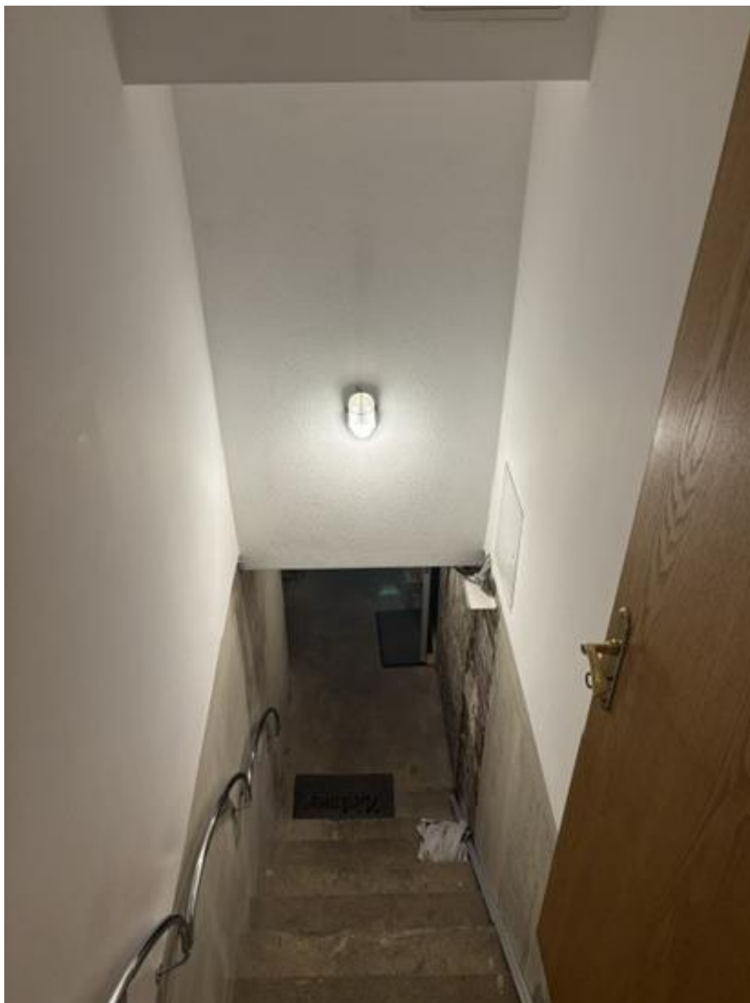
Bild 49 - Kellertreppe, Abgang, Beleuchtung
