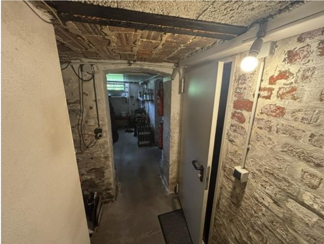
Bild 54 - Kellerflur, Ziegelwände, Durchgang
