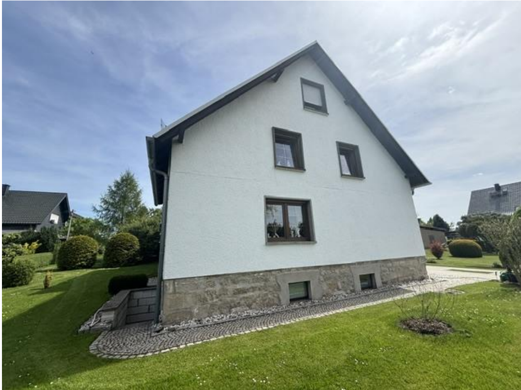
Bild 8 - Außenansicht, Giebelseite, Sockelbereich, Kellerfenster
