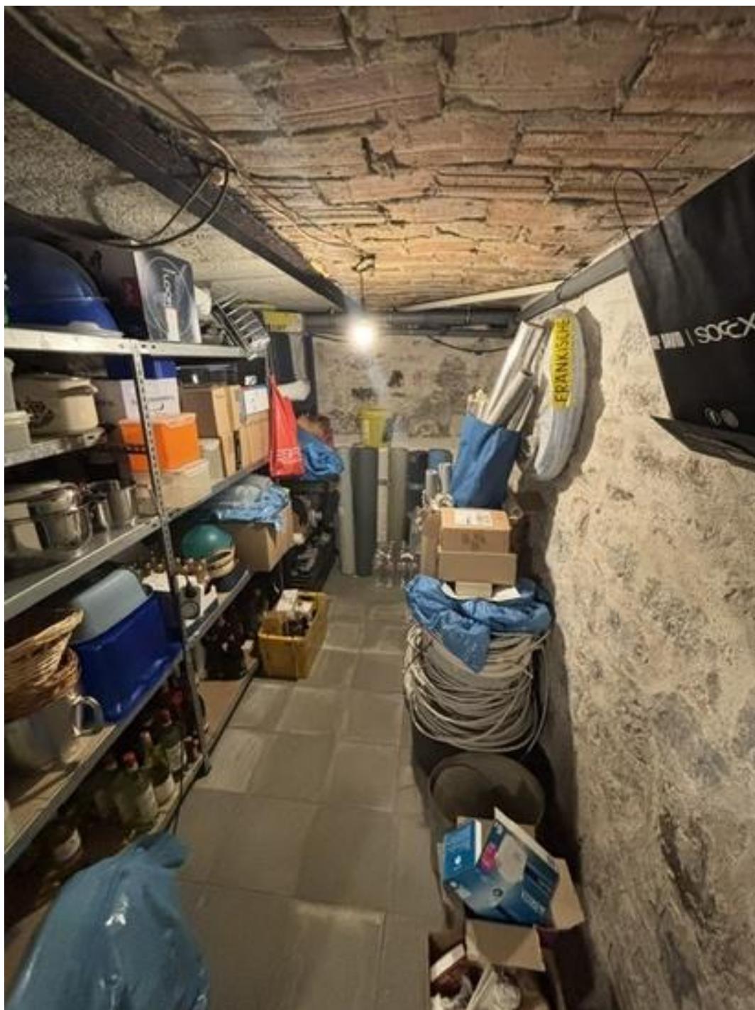
Bild 52 - Kellerraum, Natursteinwände, Ziegeldecke
