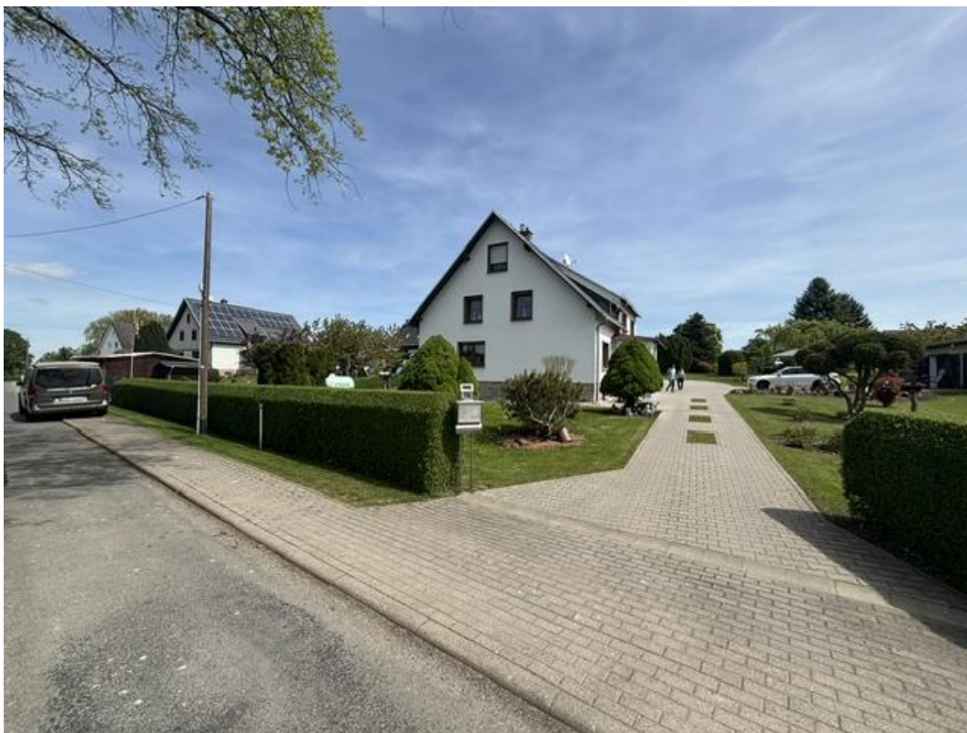
Bild 1 - Außenansicht, Ansicht Straßenseite, Einfahrt, Vorgarten
