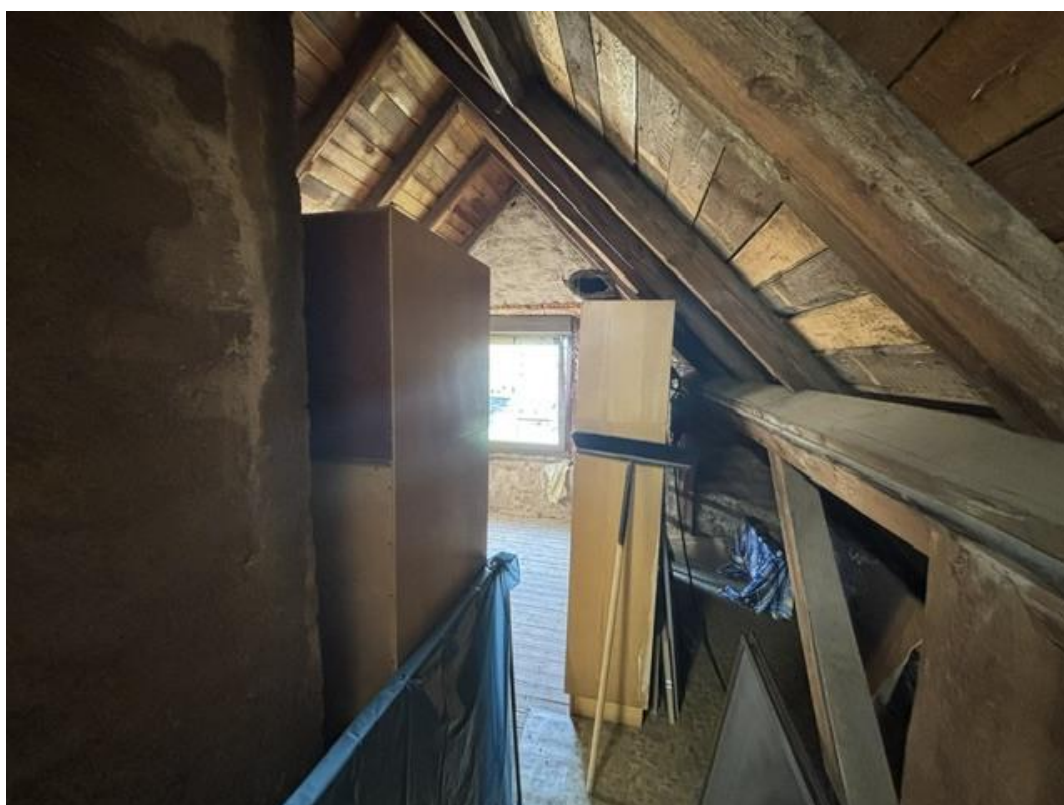
Bild 25 - Dachboden, Holztragwerk, Abstellbereich
