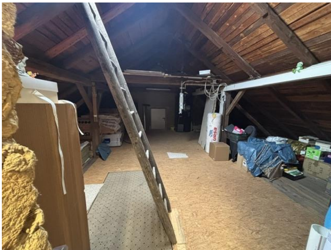
Bild 27 - Dachboden, Spitzboden, Holztragwerk, Leiterzugang
