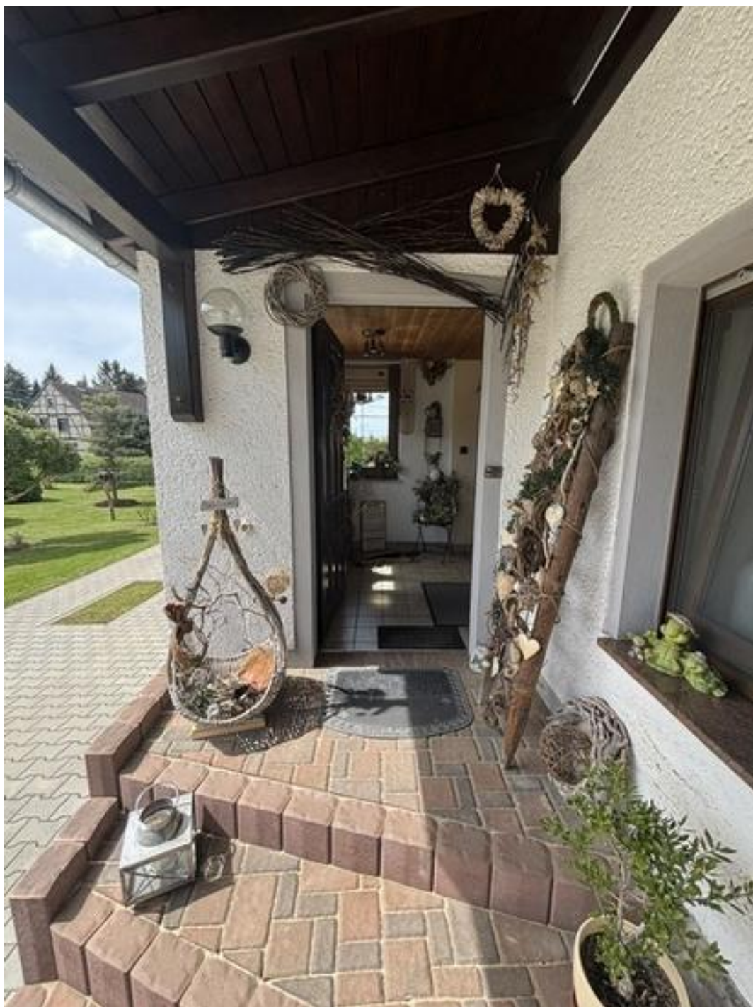
Bild 18 - Hauseingang überdacht, Eingangspodest, Klinkerpflaster
