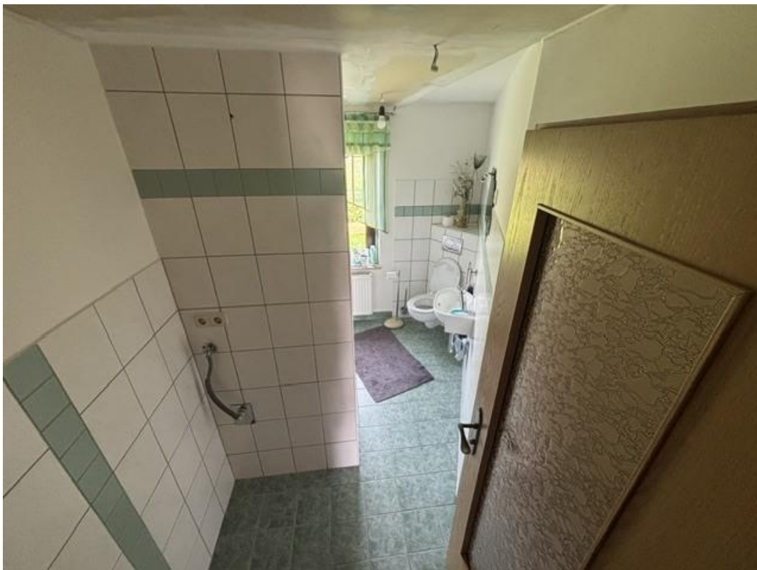
Bild 42 - Bad, gefliest, Sanitäranschlüsse, EG
