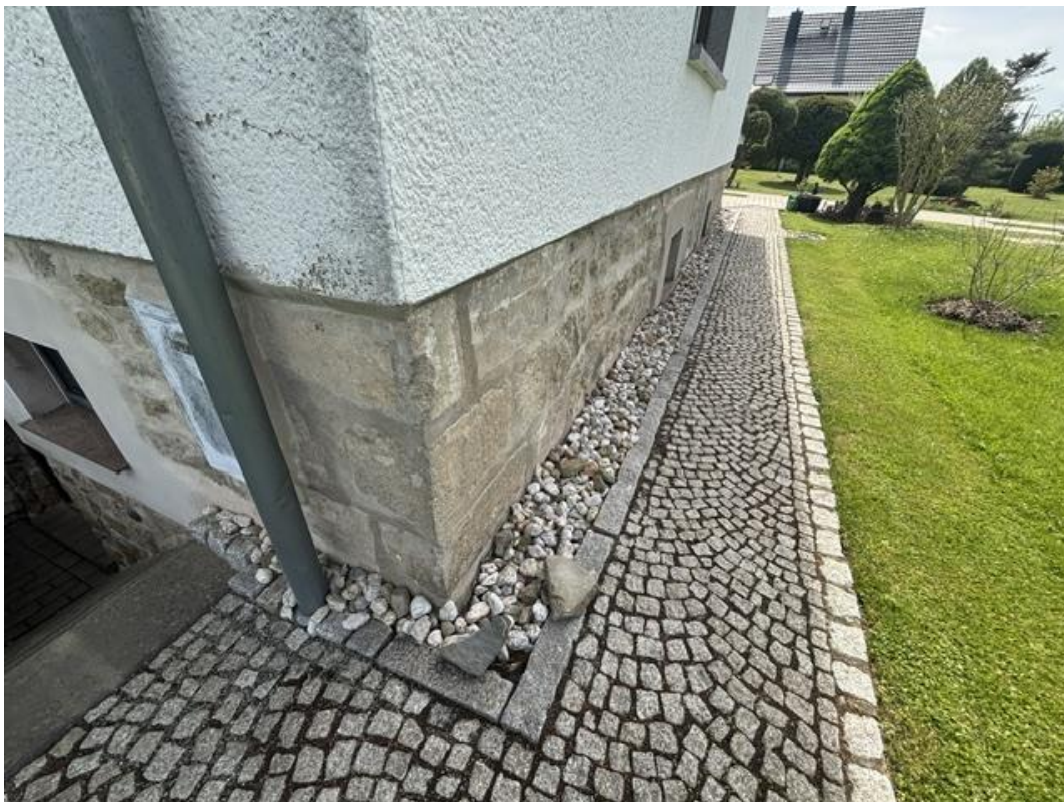
Bild 15 - Außenansicht Sockelbereich, Kiesstreifen, Pflasterweg, Fallrohr
