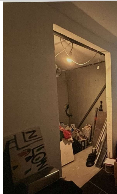
UG Bad teilausgebaut
