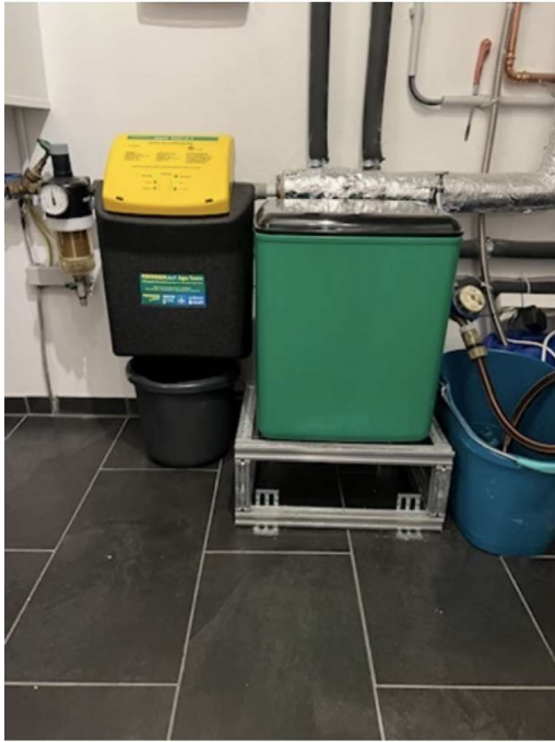
Wasserenthärtungsanlage
