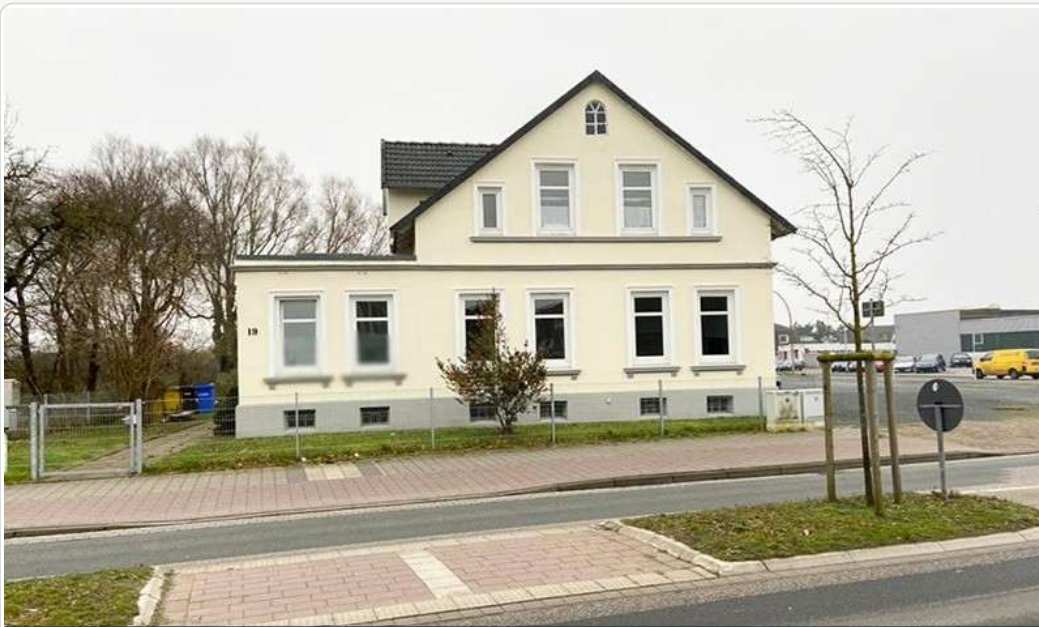
2-Parteien-Wohnhaus an der Brockeswalder Chaussee
