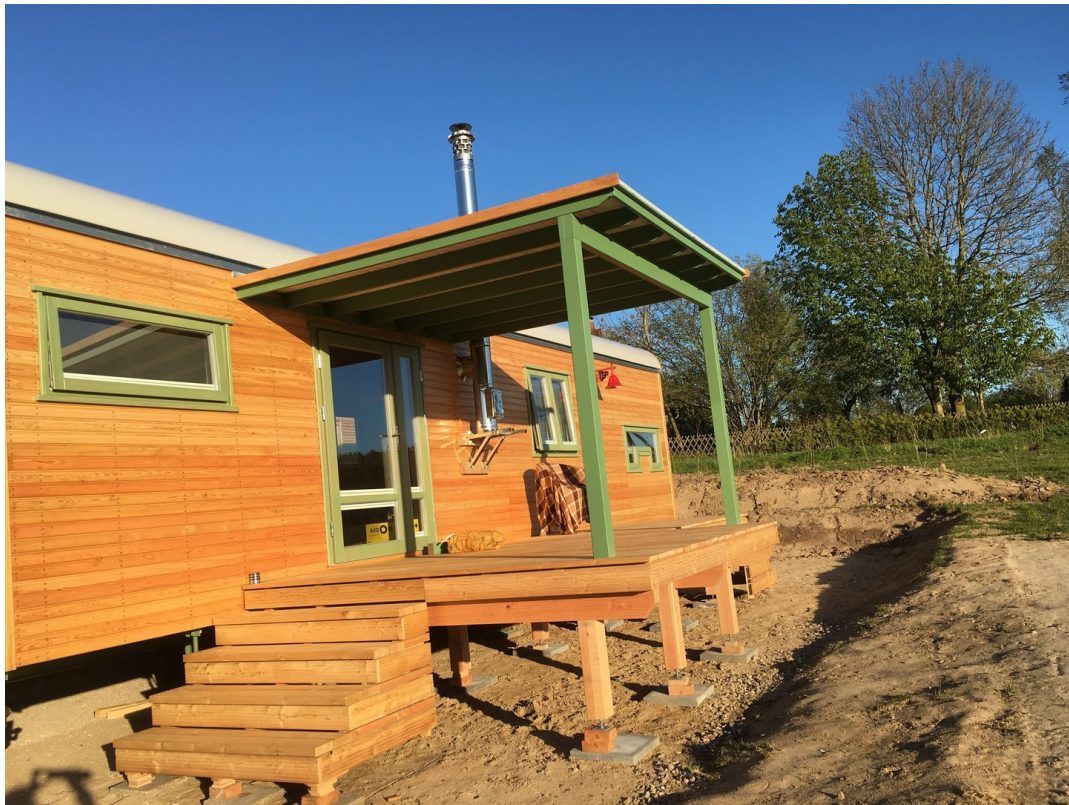
Südwest-Seite nach Aufbau
