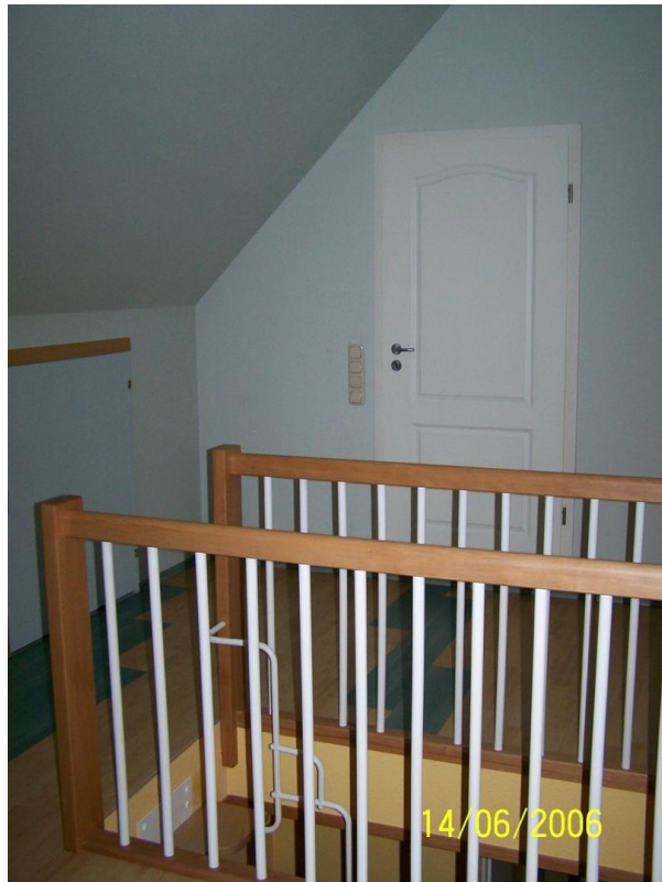
Geländer im DG
