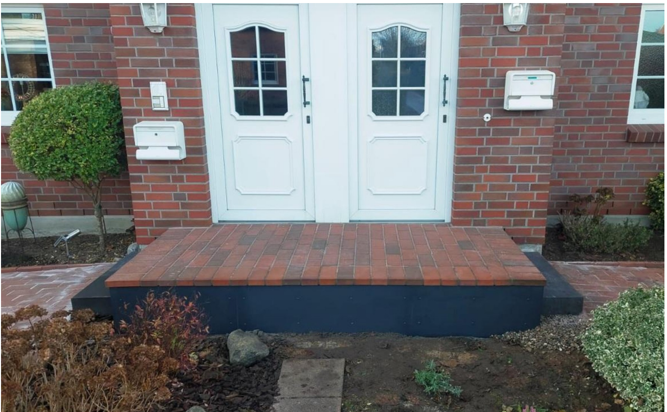
Erneuerung des Eingangsbereich
