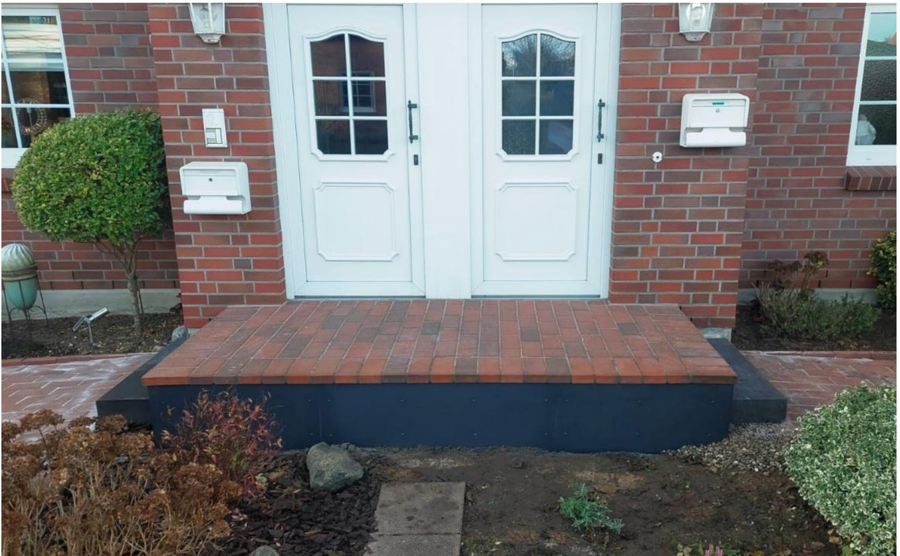
Erneuerung des Eingangsbereich
