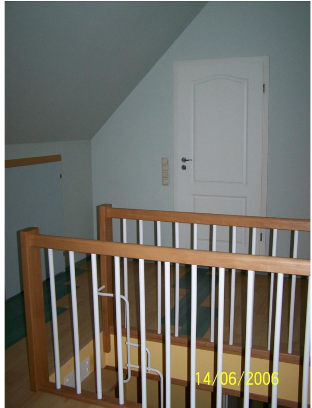
Geländer im DG
