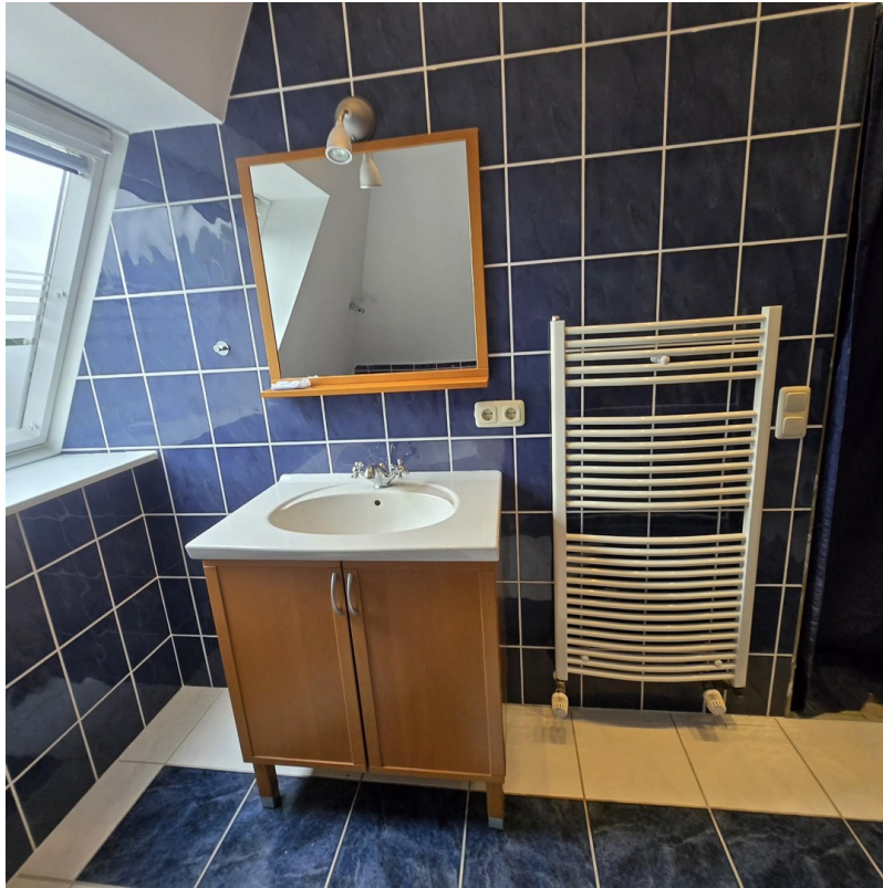
Waschtisch & Handtuchheizk. DG
