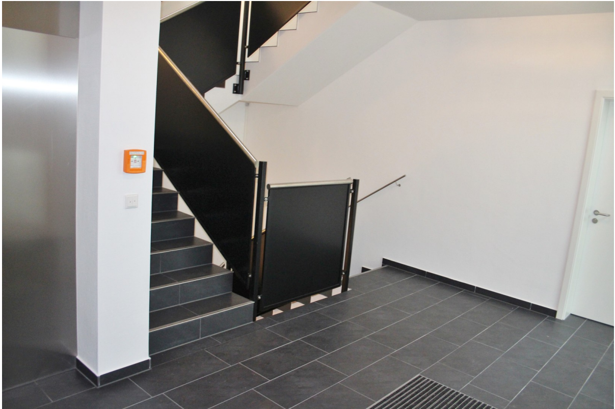
Treppenhaus mit Fahrstuhl
