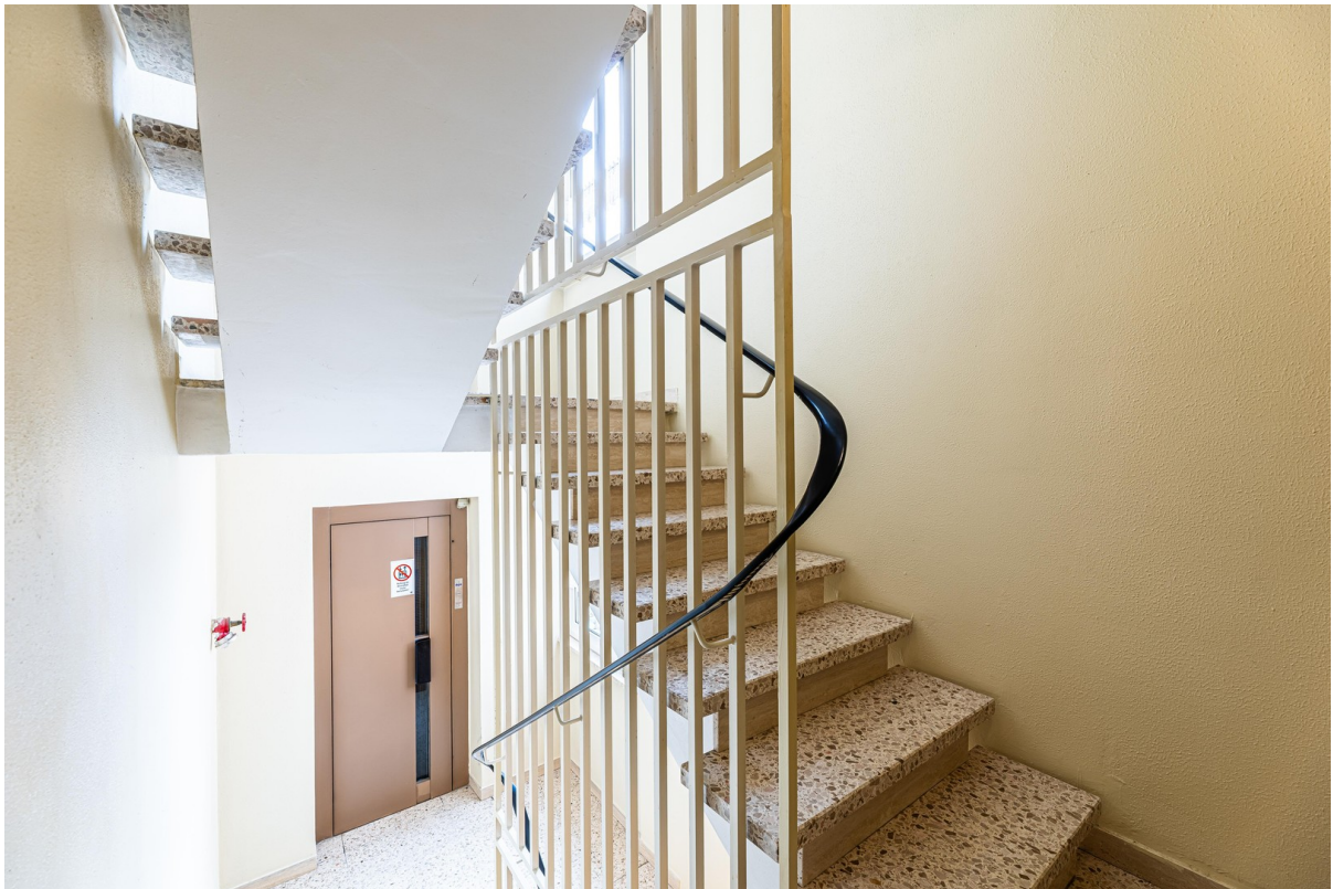
Treppenhaus mit Aufzug
