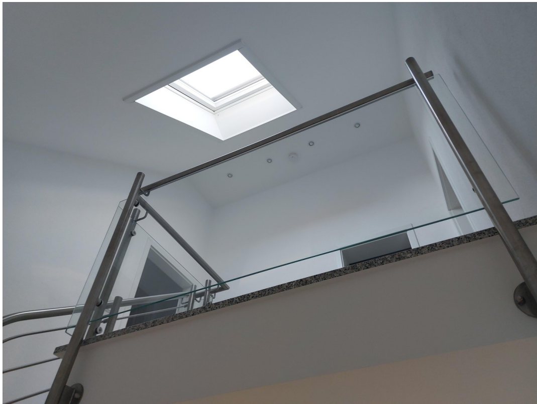
Treppe zum DG
