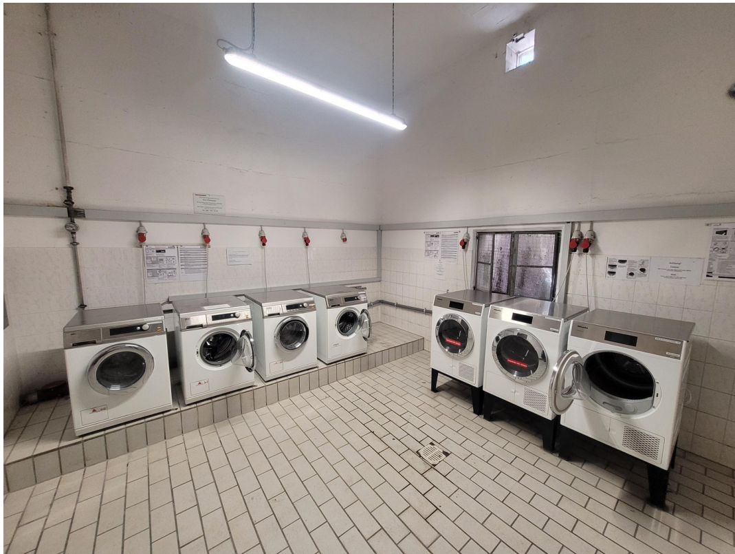
Waschraum und Trocknerraum
