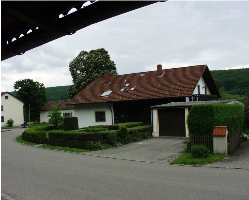
Hausansicht mit Garage
