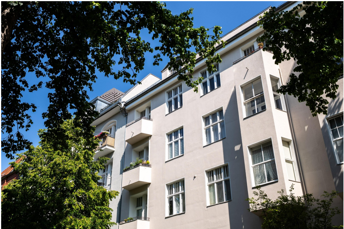
Die sanierte Fassade
