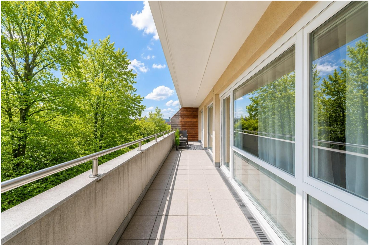
Dachterasse mit Weitblick
