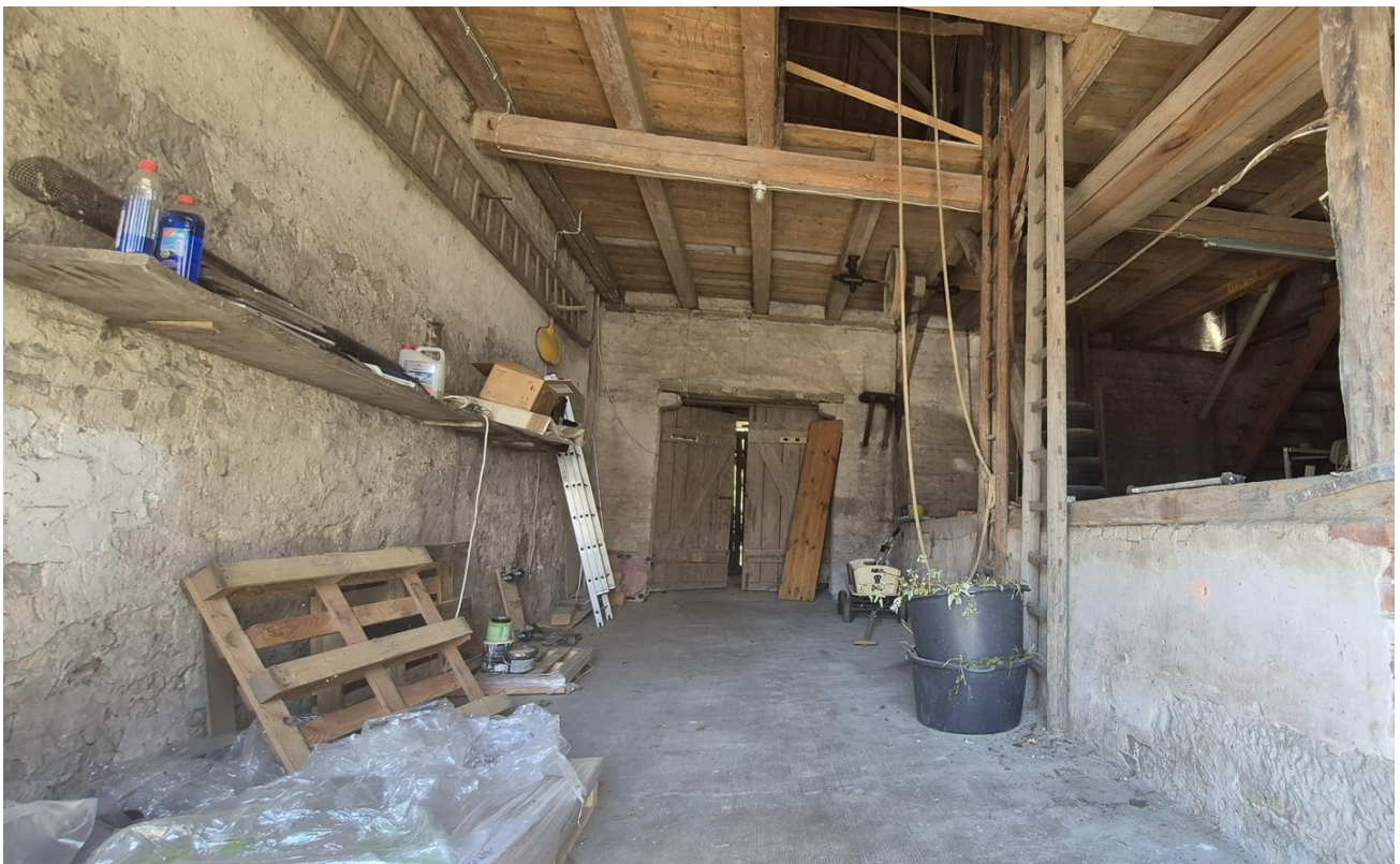
Scheune mit elektrischem Tor
