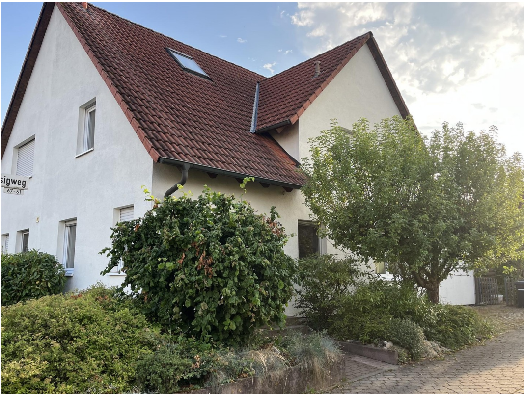
Straßenansicht des Hauses
