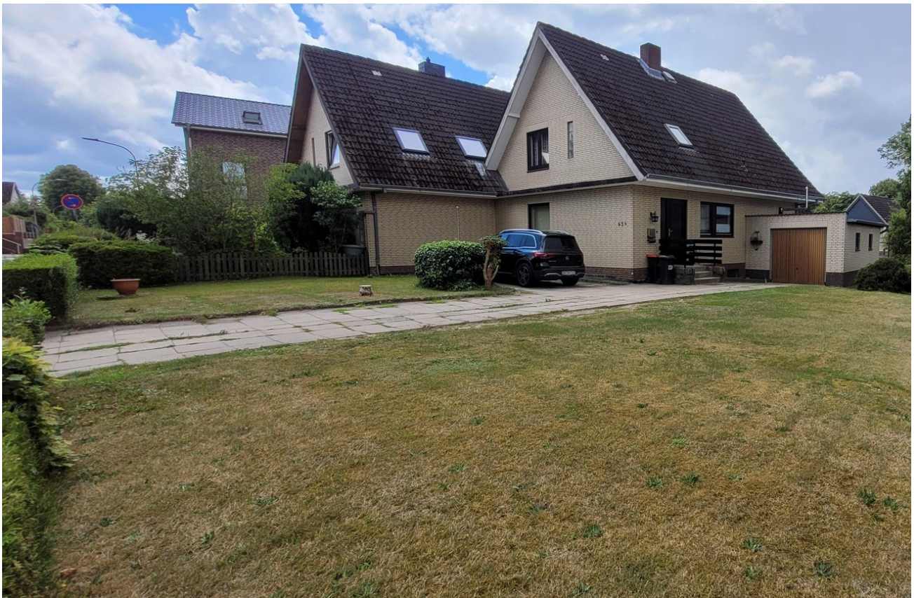
Eckansicht vorderes Grundstück
