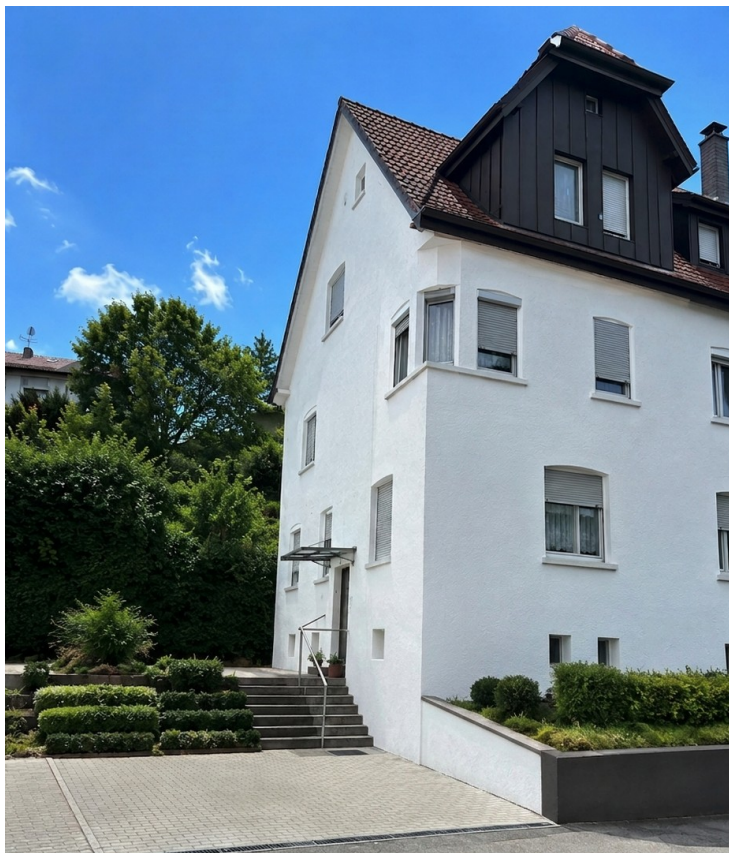
Kernsanierung mit Wärmedämmung
