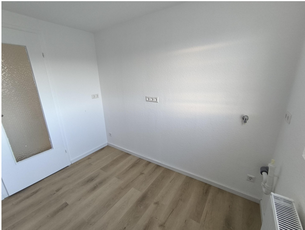
Küche, Anschluss Waschmaschine
