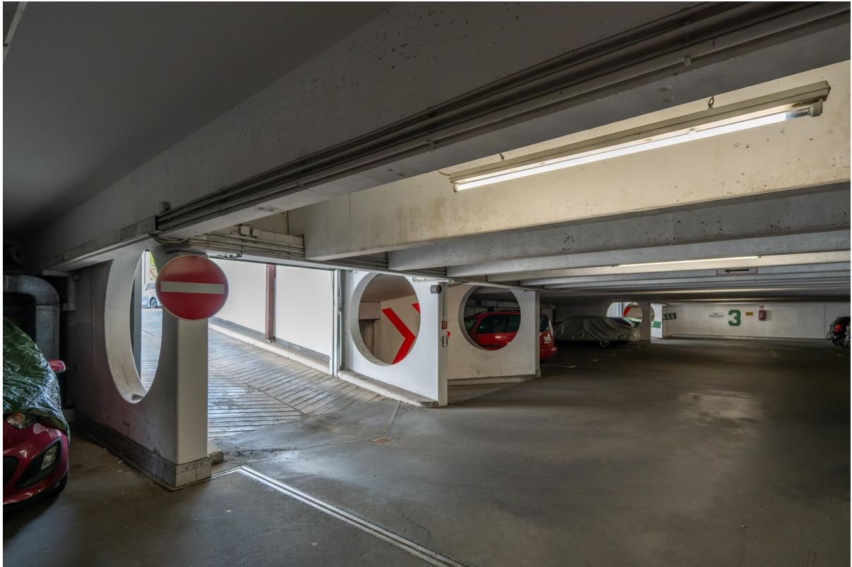
Eingang TG Einfahrt
