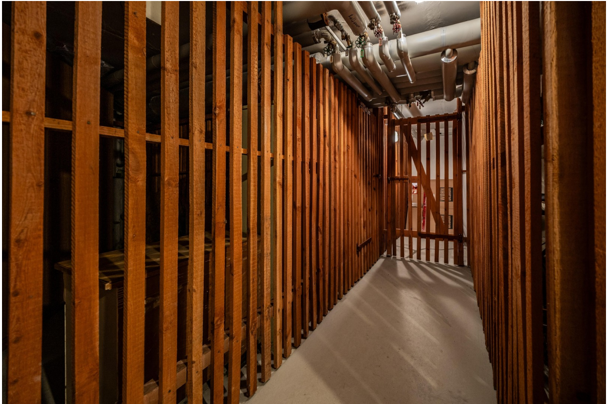
Keller mit Kellerabteil
