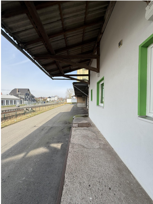
Rampe hinter dem Bürobereich
