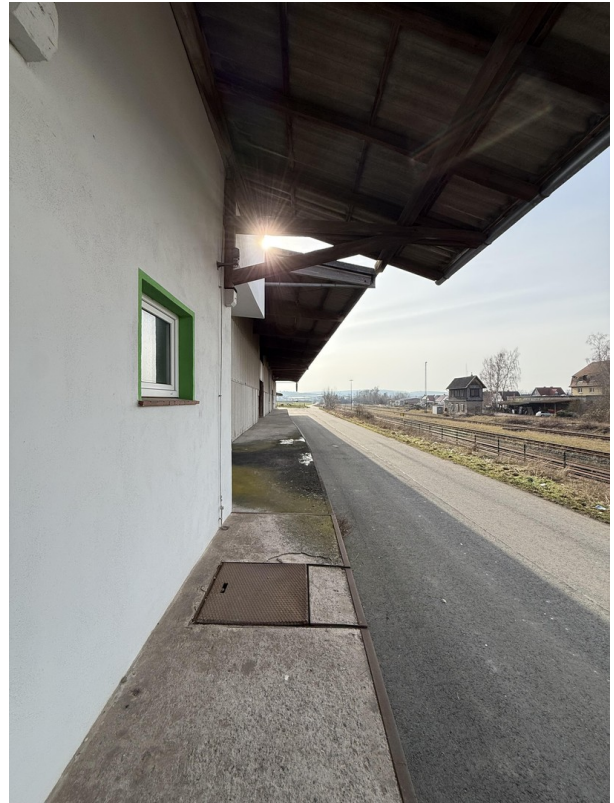
Rampe hinter dem Bürobereich
