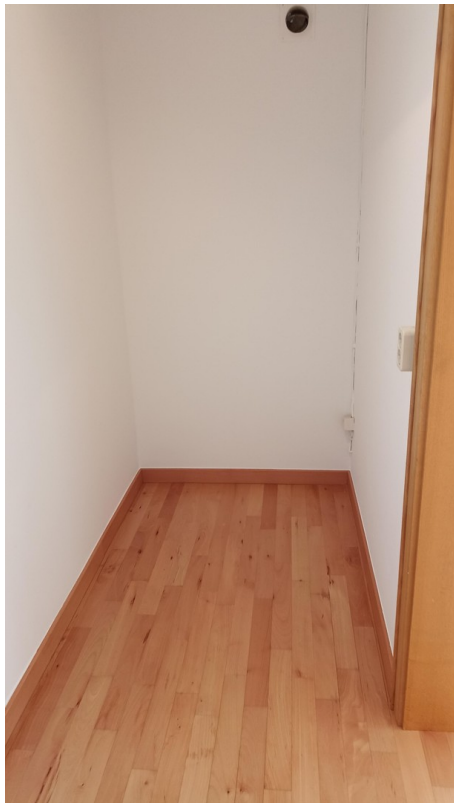
Speisekammer mit Lüftung
