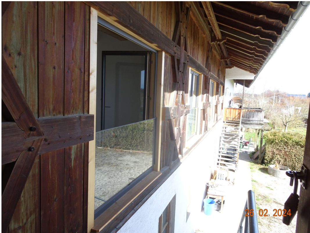
Südansicht mit Fenster
