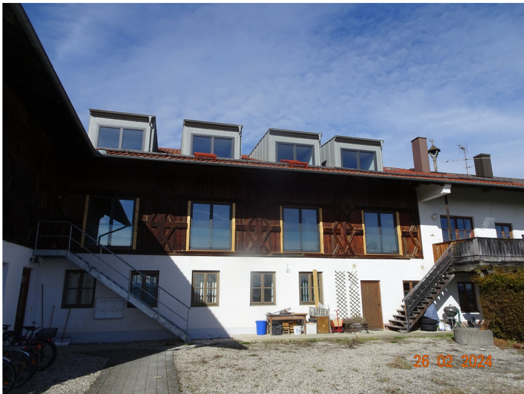
Dachgauben von links die zwei
