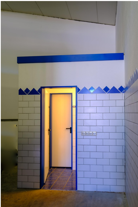
Halle B WC Bereich
