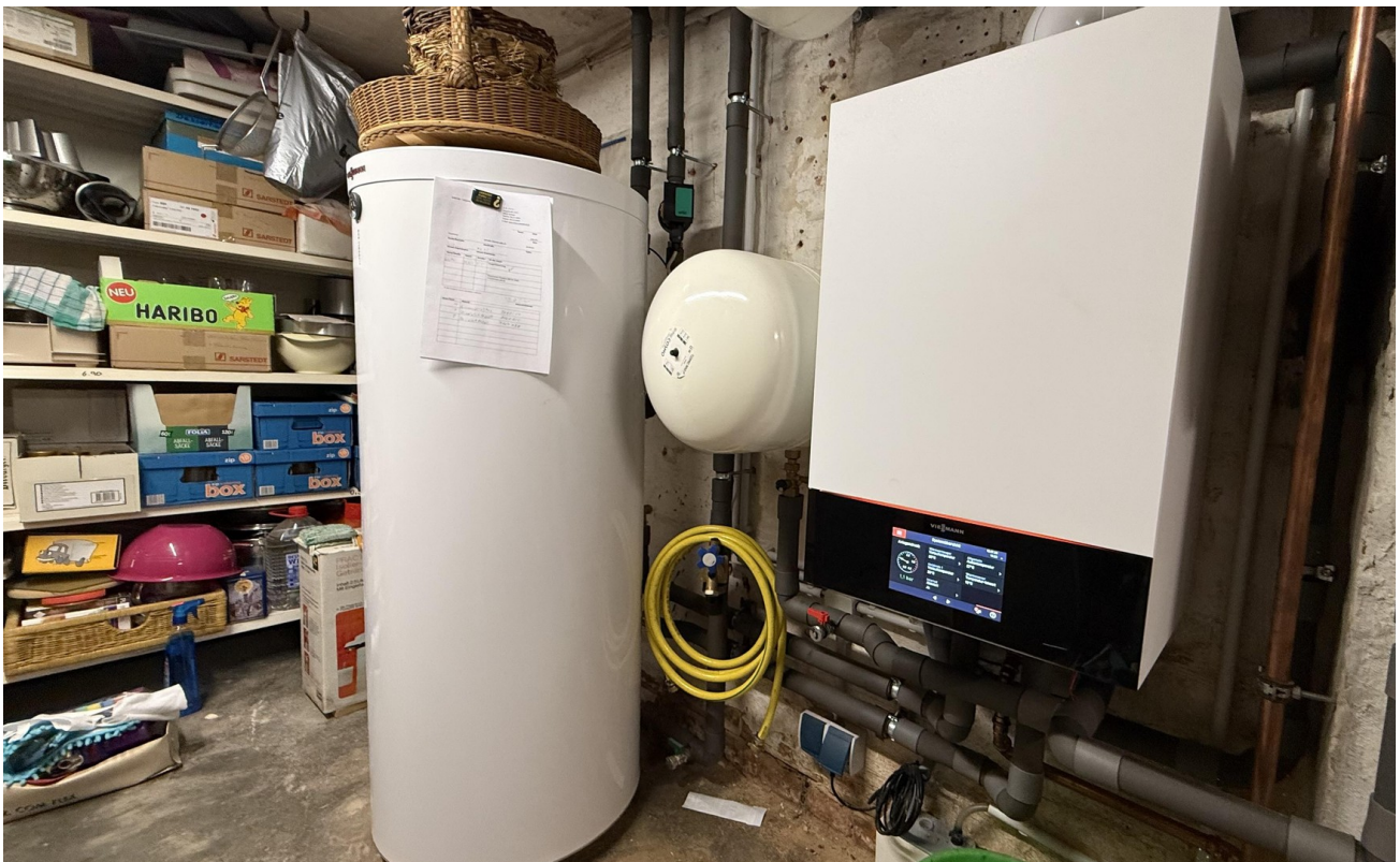
Gasbrennwerttherme Viessmann
