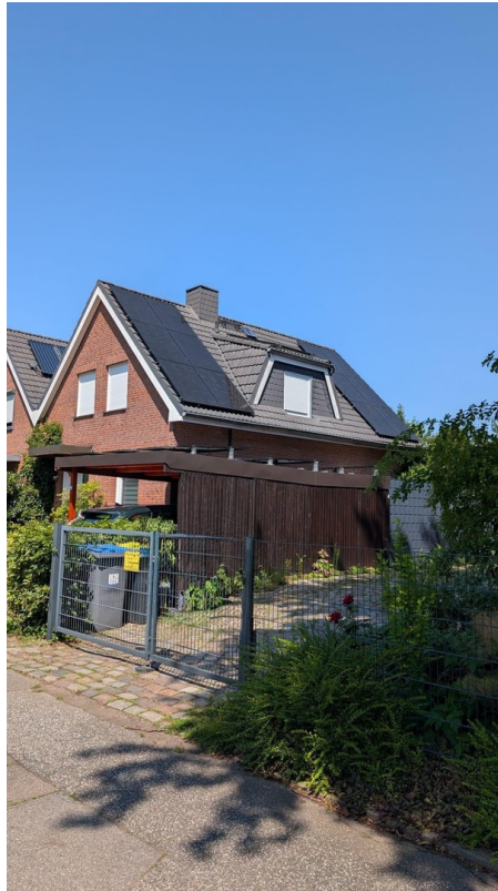
Seitenansicht mit PV
