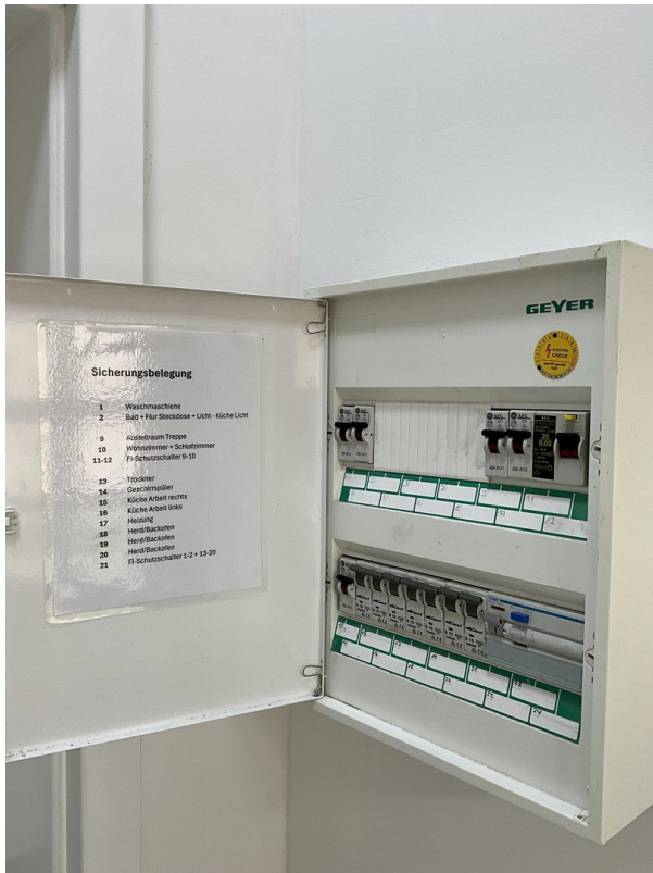
Sicherungskasten
