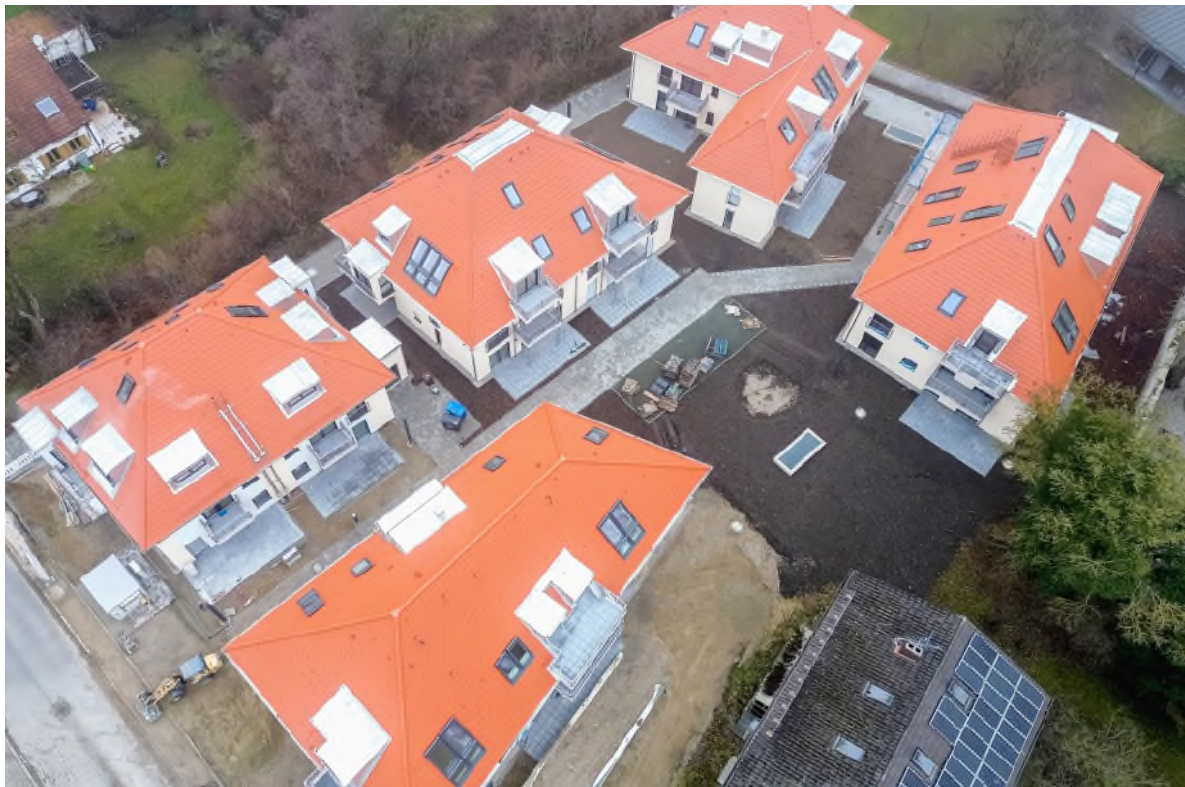
Ansicht Wohnanlage | Aktueller Baufortschritt
