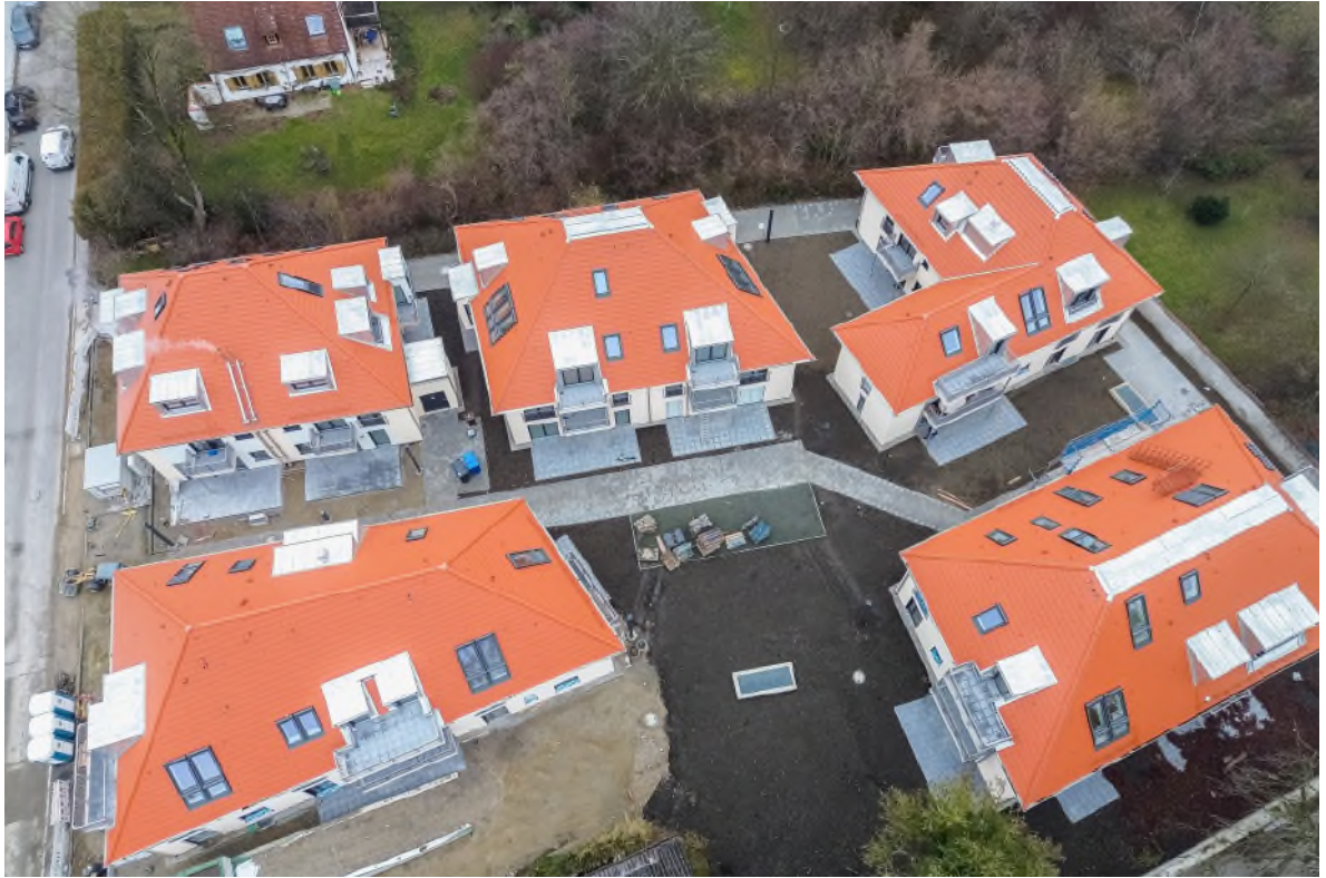
Ansicht Wohnanlage | Aktueller Baufortschritt
