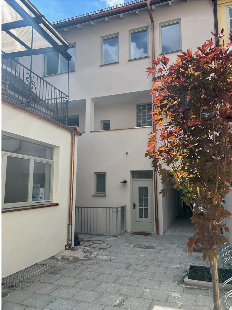
Innenhof mit Laubengang
